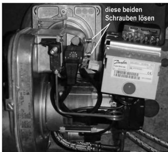
Abbildung 26 Steuereinheit abgenommen
